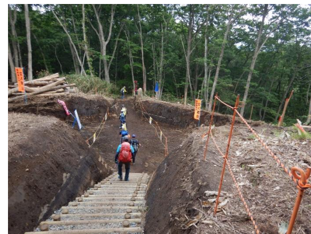
(馬返し登山口付近登山道の治山作業道作設工事)
