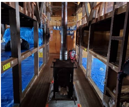
ストーブ設置状況
