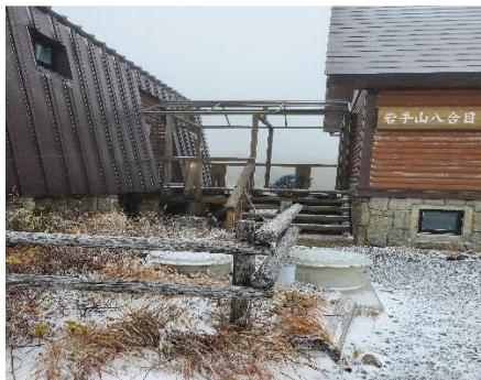
小屋からトイレへの渡り廊下屋根撤去
