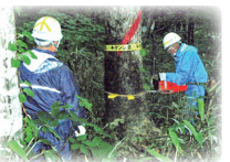
危険木の処理
