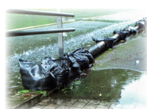
豪雨に備えて土嚢を積み
